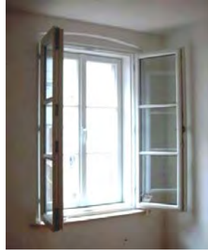
Abb. 68 und Abb. 69: Fassade nach der Sanierung; Neue Kastenfenster [Quelle: ORTLER, A., et al. (2005)]
