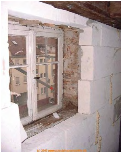
Abb. 6: Anbringen von Innendämmung Abb. 7: Innenraum nach der Sanierung [Quelle: http://www.passivhausprojekte.de/projekte.php?detail=488 ]
