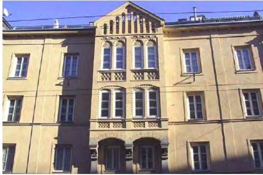
Abb. 68 und Abb. 69: Fassade nach der Sanierung; Neue Kastenfenster [Quelle: ORTLER, A., et al. (2005)]
