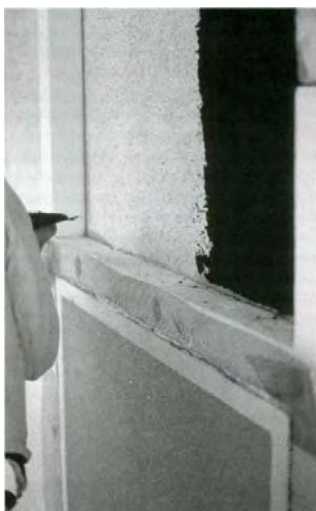
Abb. 59: Montage der TWD-Elemente, [Quelle: HALLER, A. et al. (2000)]
